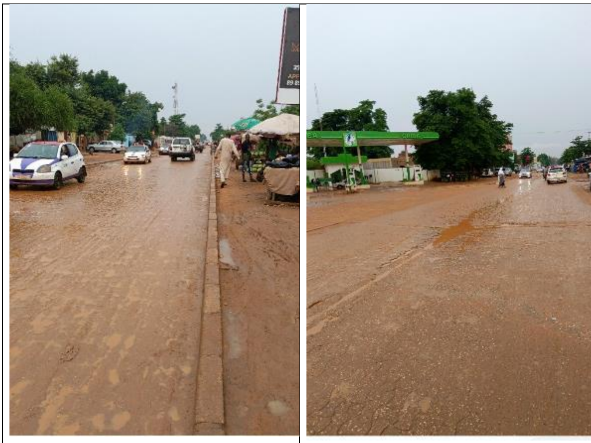
Planche 1. Vue de la rue pavée de Chateau 8-Niamey Nyala
